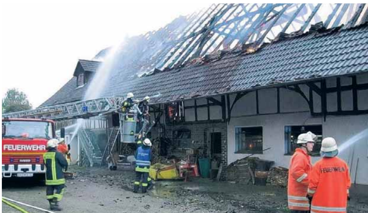
Mit vereinten Kräften löschten die Feuerwehren Bergatreute und Umgebung den Ökonomieteil des Bauernhauses in Bergatreute-Giesenweiler.
